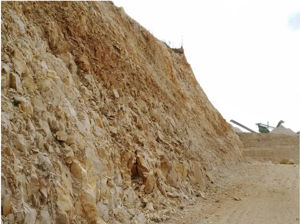
Foto 6.4 - Si nota come la scarpata non sia verticale, ma inclinata attorno agli 80^\circ , il che aumenta ancora di più la stabilità dell'insieme. L'ammasso roccioso si presenta con giacitura sub-orizzontale, quindi stabile, e privo di giunti di fessurazione significativi.
