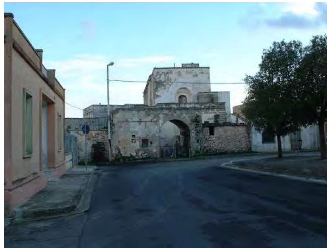
Foto 3.29 - Ingresso a Masseria S. Barbara.
