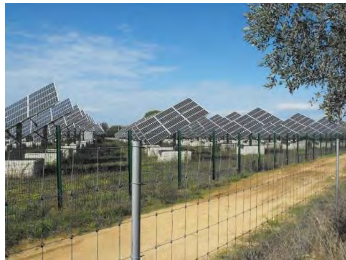
Foto 3.25 – Impianto fotovoltaico in campo nelle immediate vicinanze della cava in esame.
