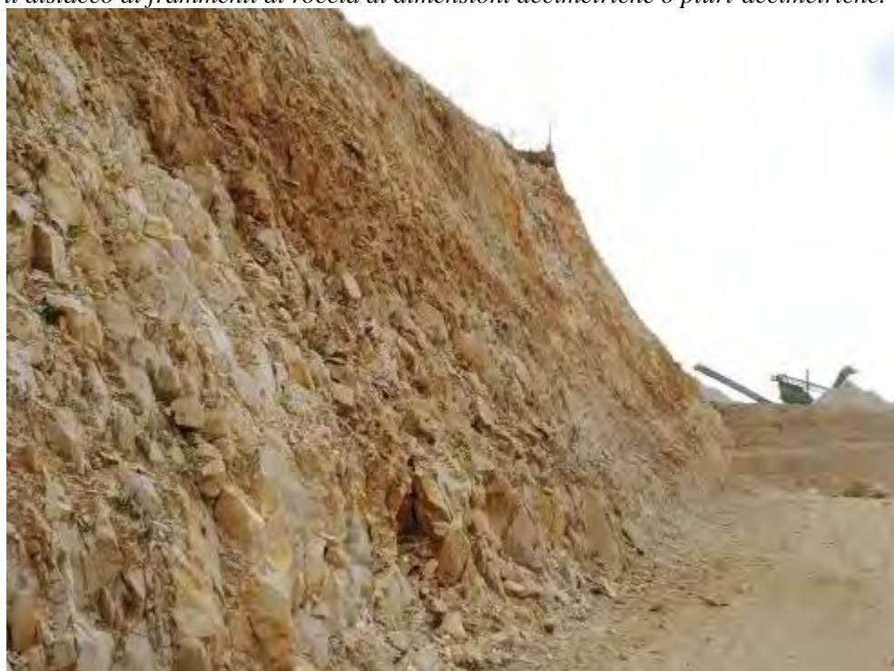
Foto 3.20 - Si nota come la scarpata non sia verticale, ma inclinata attorno agli 80°, il che aumenta ancora di più la stabilità dell’insieme. L’ammasso roccioso si presenta con giacitura sub-orizzontale, quindi stabile, e privo di giunti di fessurazione significativi.
