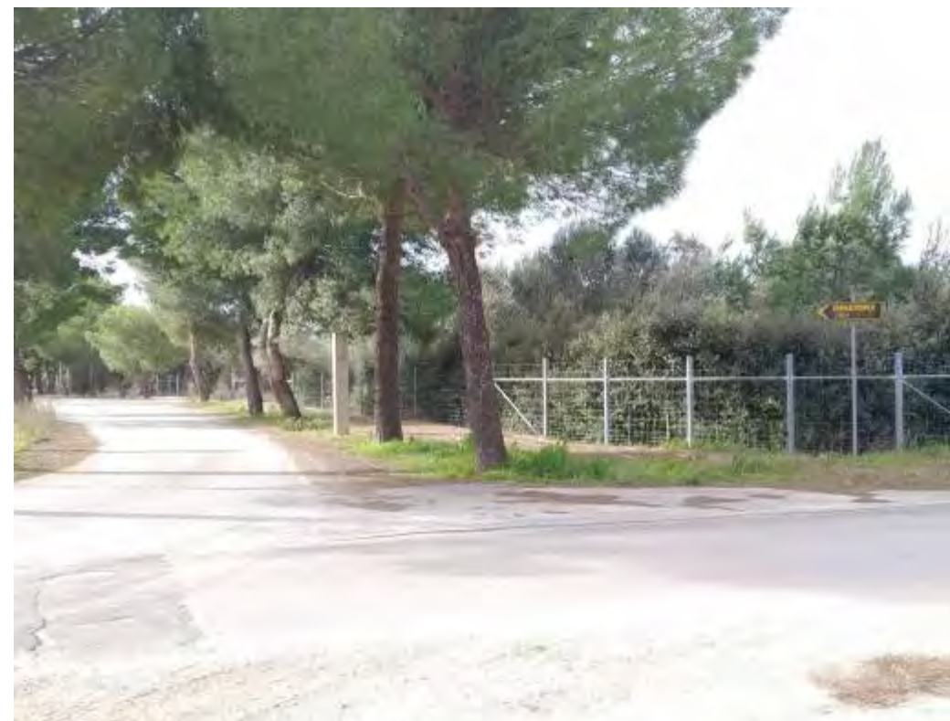
Foto 4.2 - L'intera area è già munita di recinzione con paletti e rete metallica.
