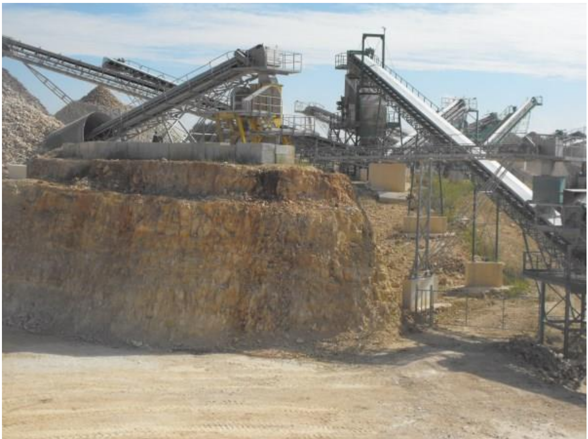
Foto 17 – Tutti i nastri trasportatori sono provvisti di carenature così da contenere le emissioni di polveri.
