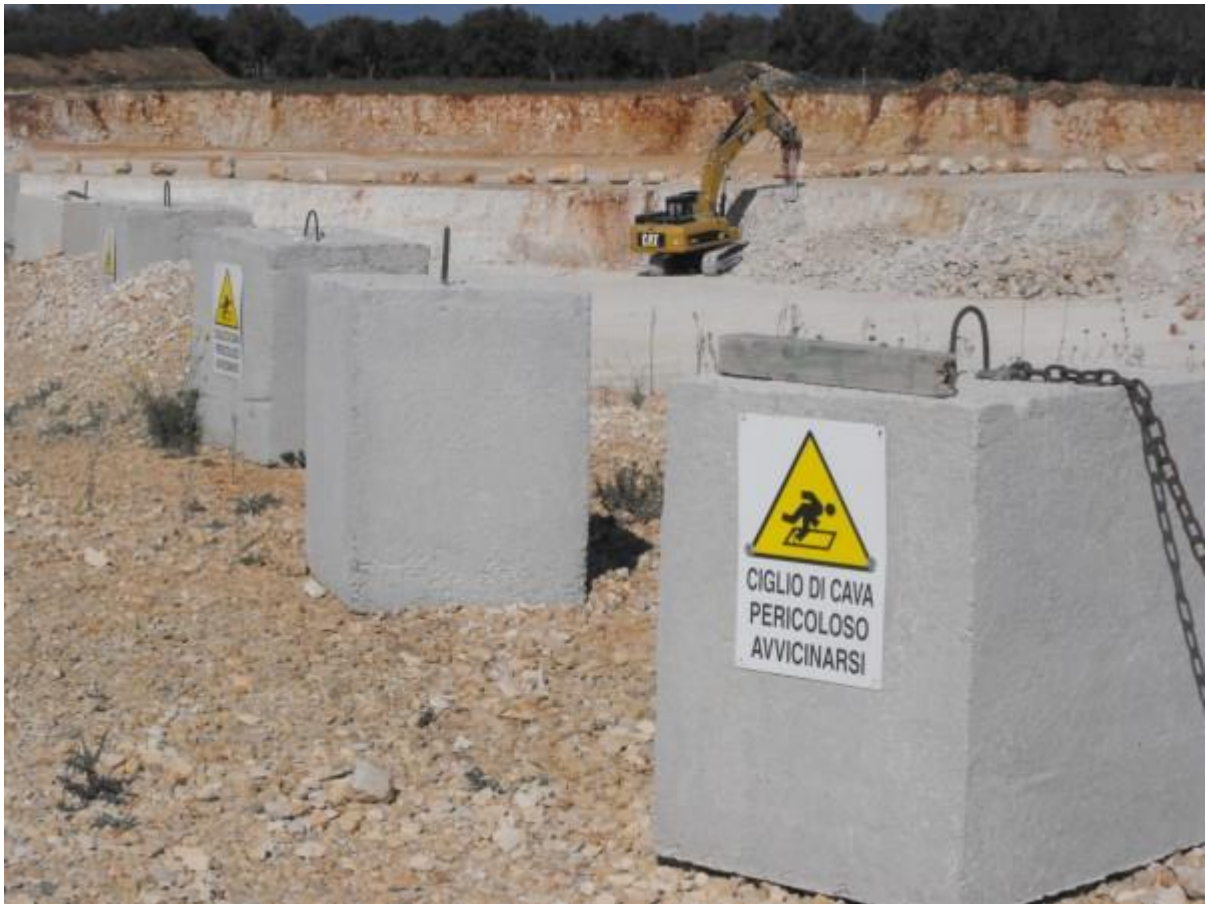
Foto 20 – I blocchi in cls posti a protezione delle pareti di scavo
