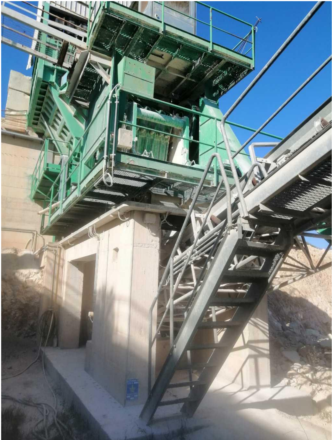
Foto 11 – Impianto di frantumazione
