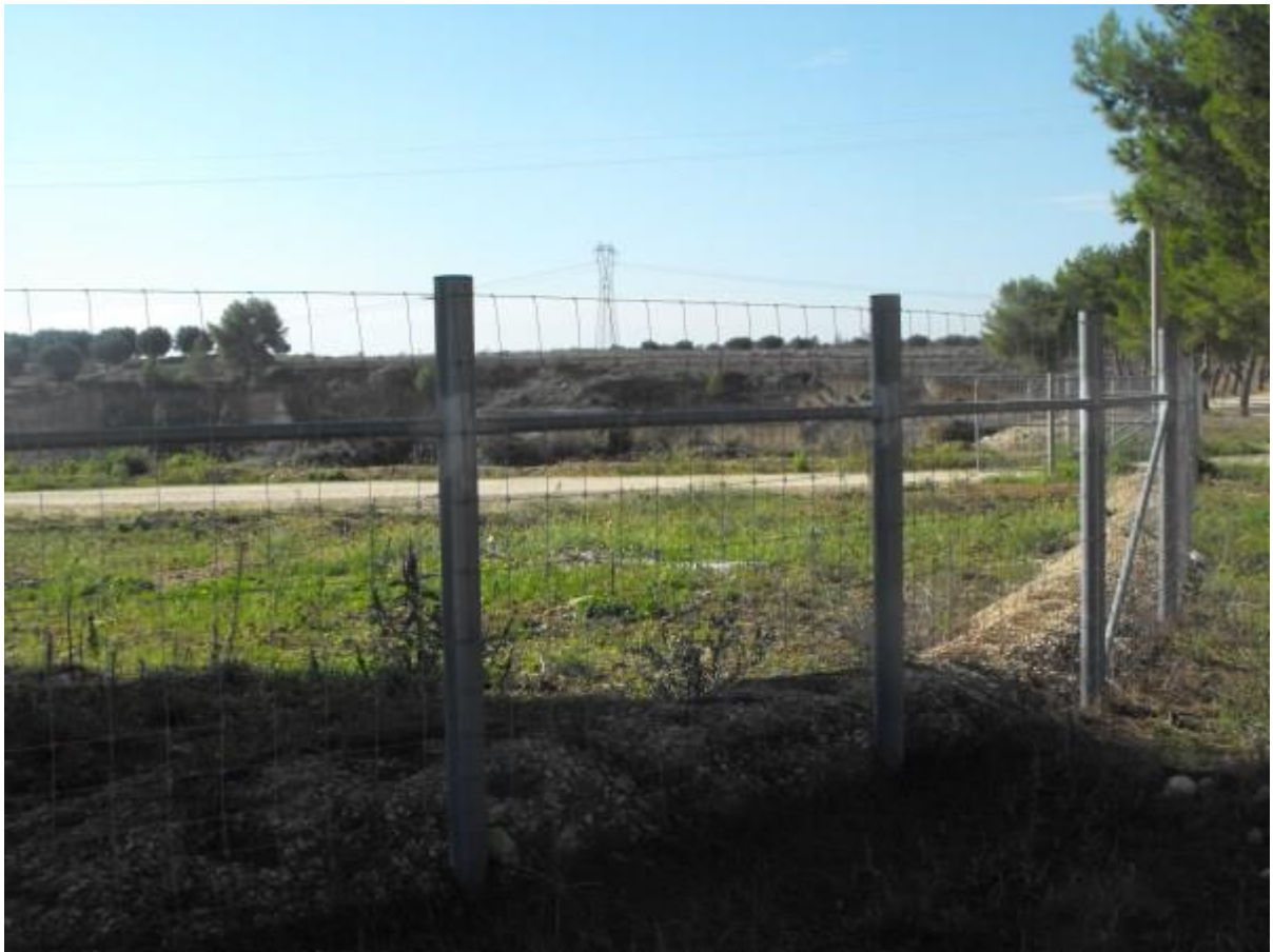
Foto 5 – Particolare della recinzione con paletti e rete metallica delimitante l'area di cava
