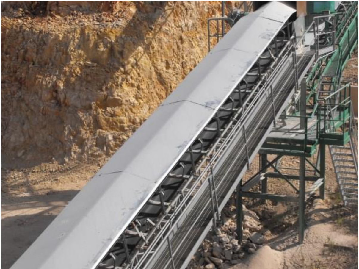
Foto 18 – Particolare delle carenature
