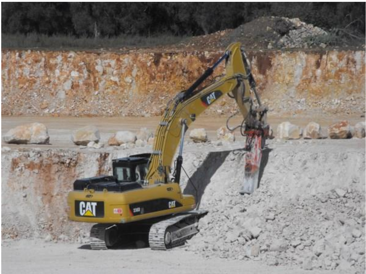
Foto 21 – L'abbattimento della roccia calcarea e il disaggio dei massi pericolanti avvengono esclusivamente mediante martellone demolitore montato su escavatore
