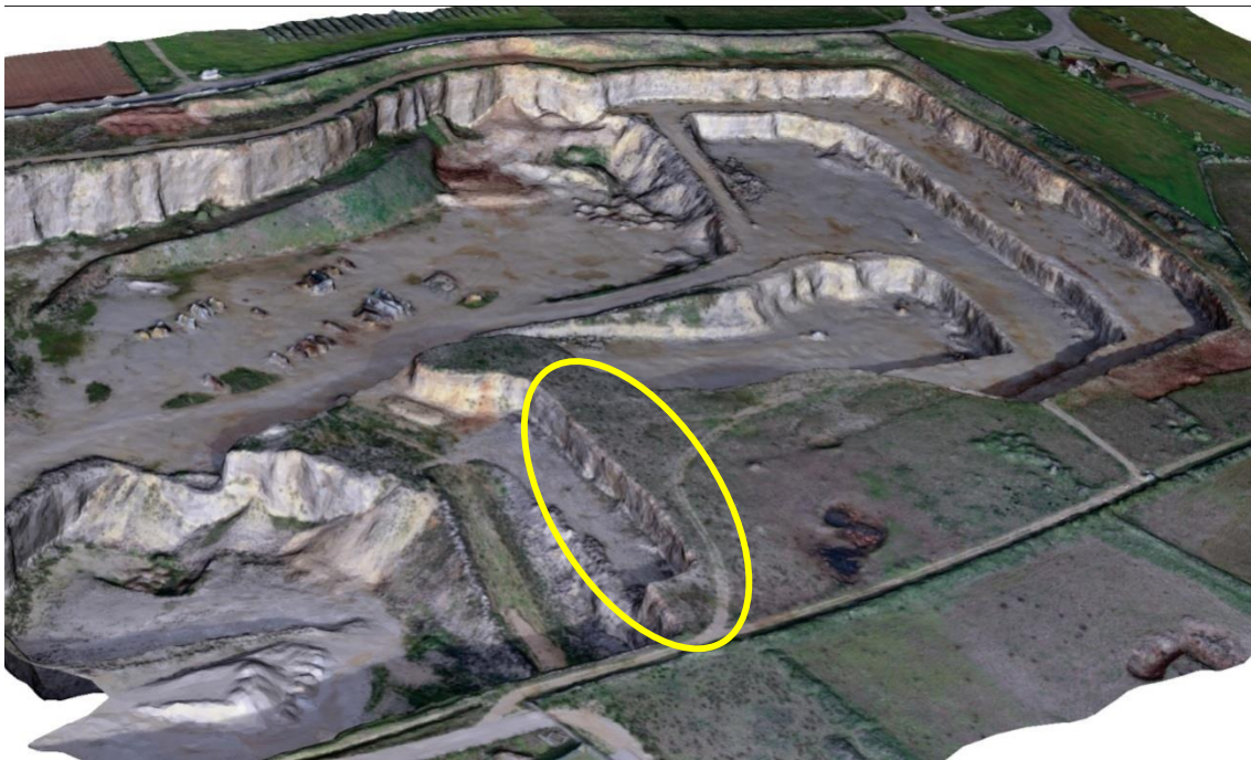
Foto F - Fronte occidentale di estrazione della particella 39 (rilievo 2018 da drone)
