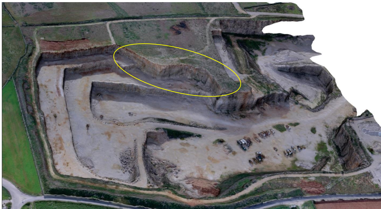
Foto H - Fronte settentrionale di estrazione della particella 39 (rilievo 2018 da drone)
