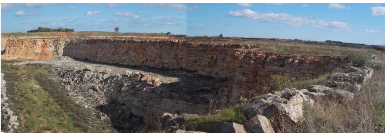
Foto G - Fronte occidentale della p.Ila 39 (da piano campagna - (rilievo 2018 da drone)
