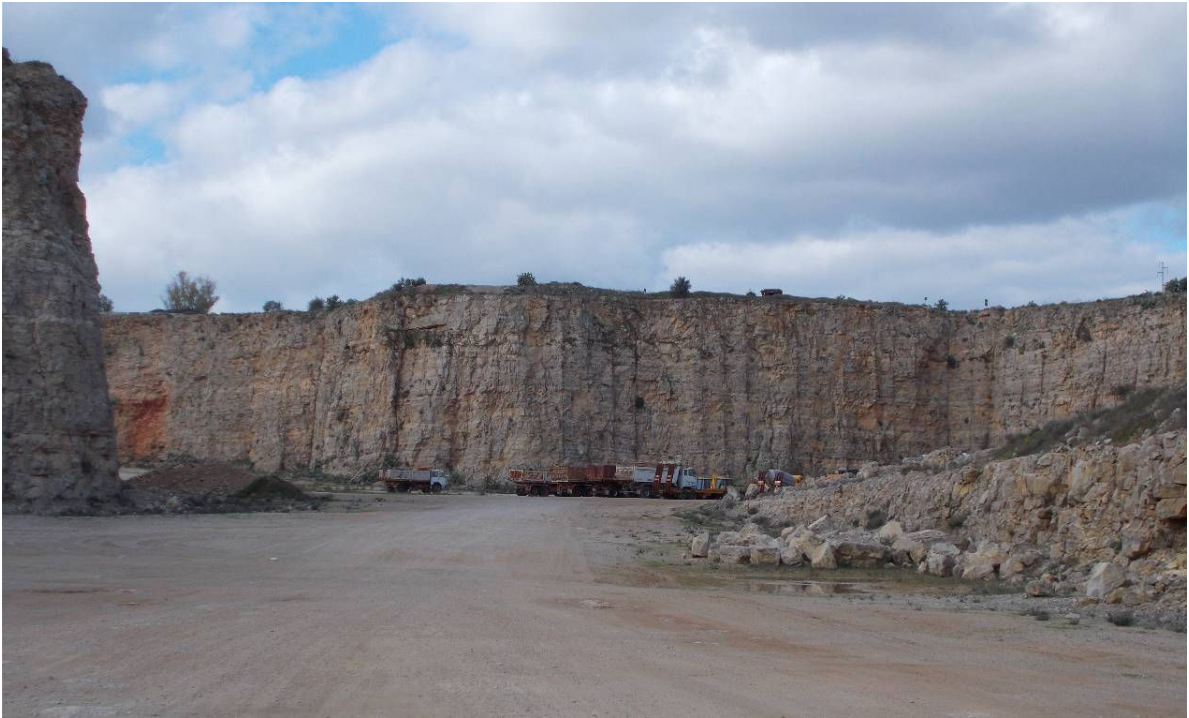
Foto 4 - Perimetro di scavo NW a fronte unico
